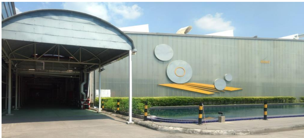
รูปภาพที่ 4 อาคารคลังสินค้าและสำนักงานของโครงการ DSG HSIL สระบุรี
