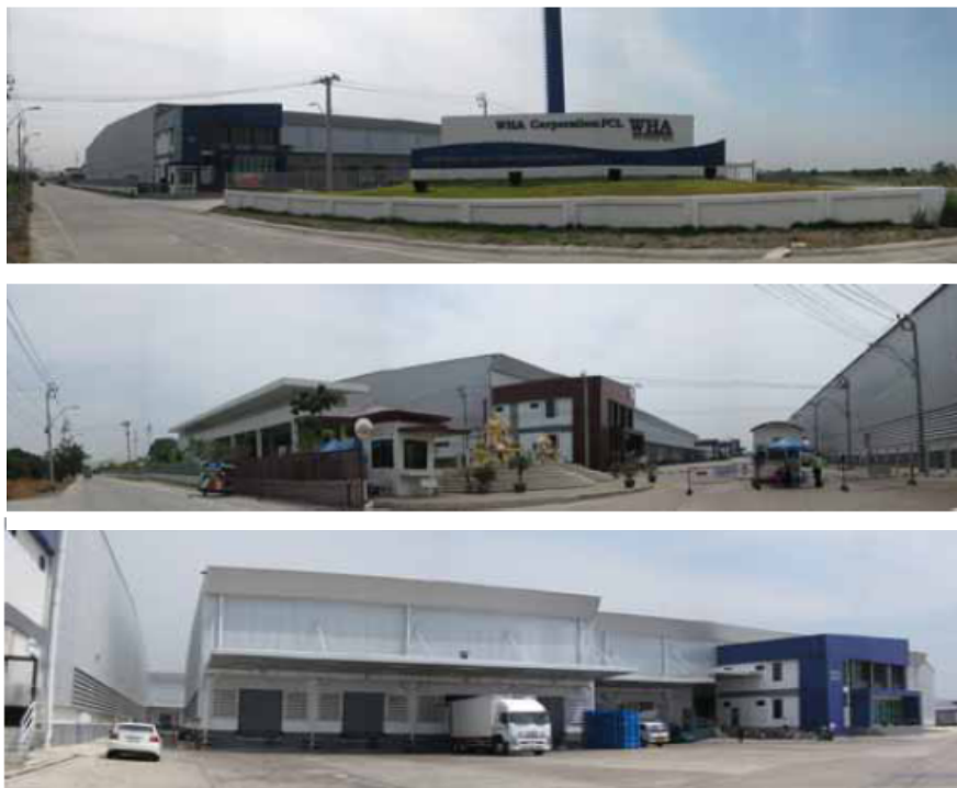
รูปภาพที่ 1 อาคารคลังสินค้าและสำนักงานของโครงการ WHA ชลหารพิจิตร กม. 5
